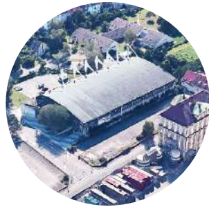
Rue Saint-Charles Gymnase des Malteries face au site Heineken
