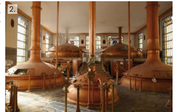
Salle de brassage et ses cuves en cuivre d'époque
